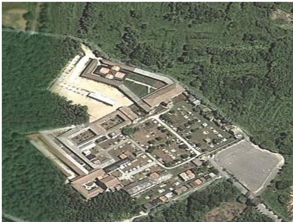
Veduta aerea dell'area cimiteriale di Serra San Bruno
